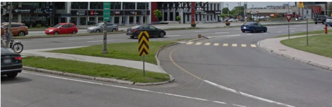
Figure 13 : Marquage inégal obligeant le piéton à faire un détour à l'intersection route de l'église et boulevard Laurier
